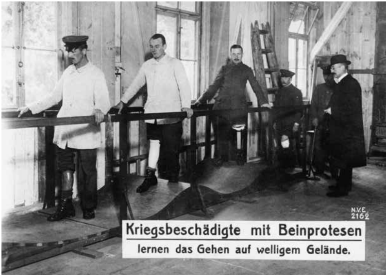
Abb. 1: Kriegsbeschädigte mit Beinprothesen lernen das Gehen auf welligem Gelände, um 1920
