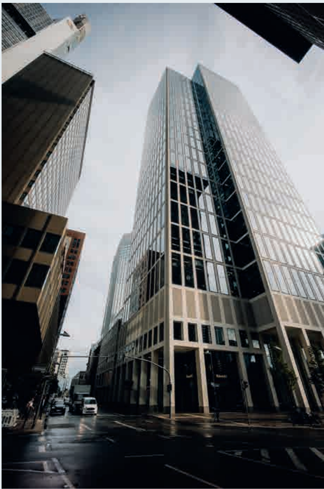
Der TaunusTurm beherbergt auch das TowerMMK – Zweigstelle des Museum für Moderne Kunst. | The TaunusTurm also houses the TowerMMK – a branch of the Museum of Modern Art.
