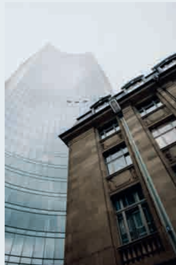
Gebäudeensemble »Skyper«: Hochhaus im Kontrast zur Holzmann-Villa von 1915. | The »Skyper« building complex: a high-rise that stands in stark contrast to the Holzmann Villa, built in 1915.
