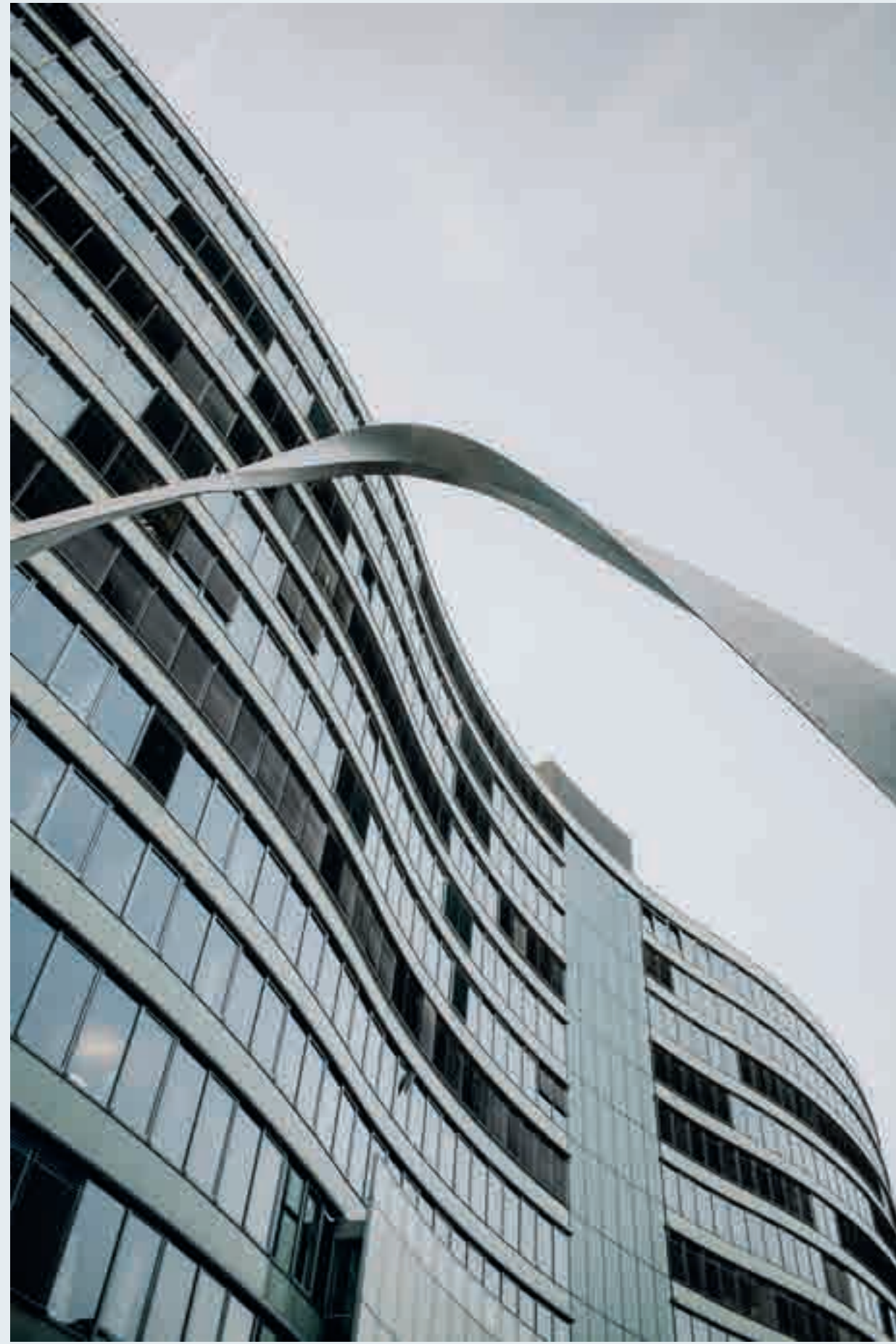
Fließende Fassade der »Frankfurter Welle« im Stadtteil Westend-Süd. Ins Bild ragt die Skulptur »die Welle« von schneider + schumacher. | The flowing façade of the »Frankfurter Welle« in the Westend-Süd district. The sculpture »die Welle« (wave) by schneider + schumacher can be seen in the picture.
